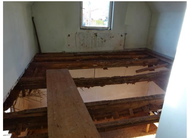
Fehlende Unterbodenkonstruktion
